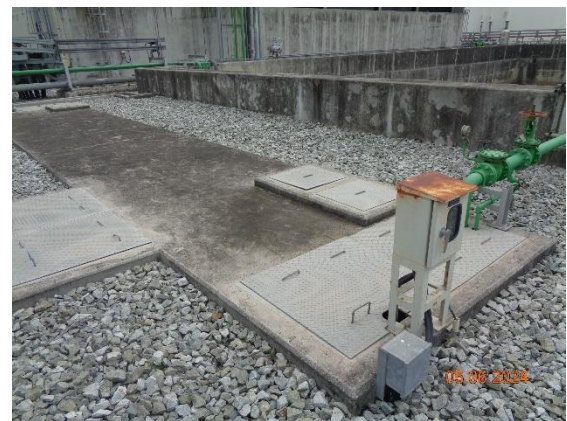
รูปที่ 2.6 ป่อแยกน้ำ-น้ำมัน
