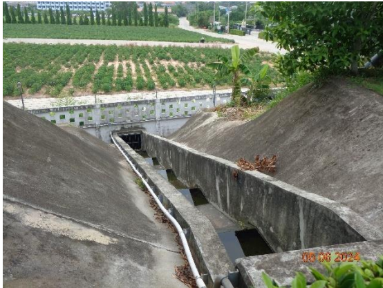
รูปที่ 2.17 จุดเชื่อมต่อระบบระบายน้ำฝน ของโครงการและนิคมฯ
